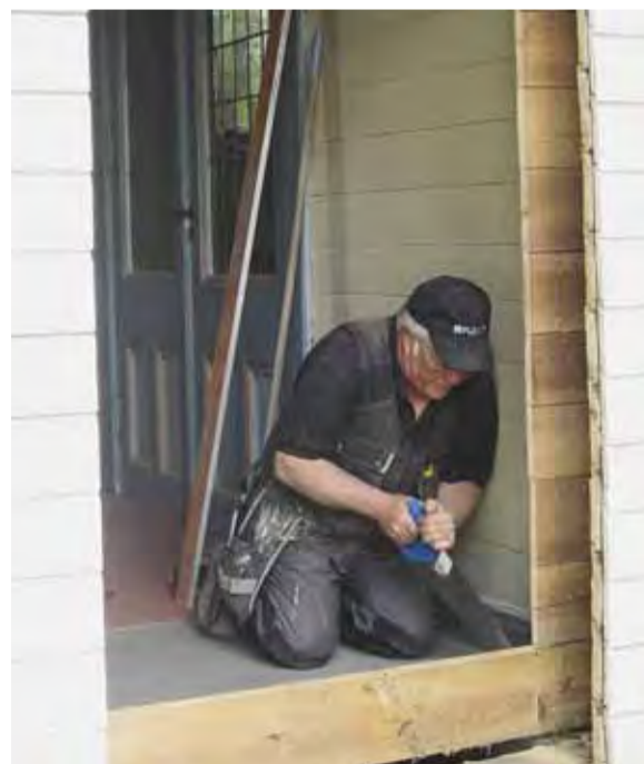
Snekker Jens Evensen forbereder montering av inngangsdør ved rullestolrampen.
